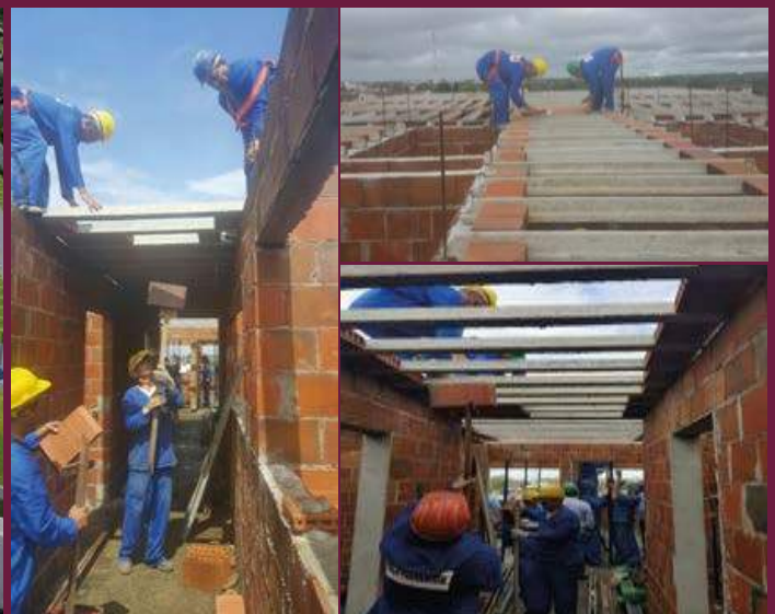
Bouw Bella Parnamirim reeds aangevangen
